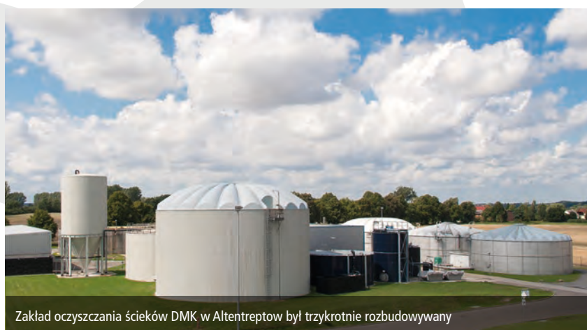
Również zachowanie odpowiednich wartości kontrolnych oraz utrzymanie dobrego stanu technicznego należy do zakresu odpowiedzialności REMONDIS Aqua
