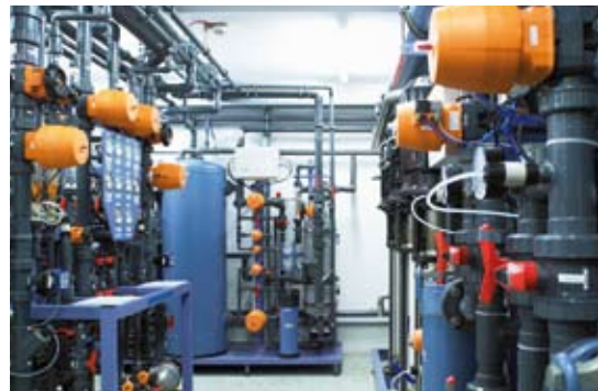
Als Contractor erweiterte REMONDIS Aqua die Anlagen der WILD Valencia S.A. zur und übernahm die Betriebsführung. Jetzt wird bei der Abwasserbehandlung Biogas gewonnen und zur Dampferzeugung in der Produktion genutzt.
