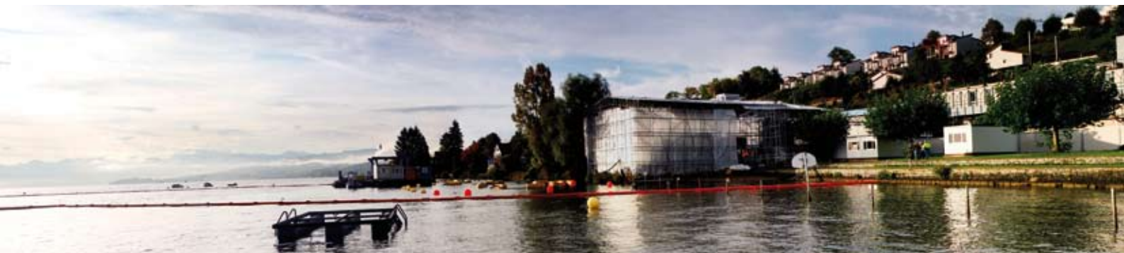
Behandlungsanlage am Ufer des Sees: Bei der Sanierung des Zürichsees kam die gesamte Leistungspalette der REMEX-Gruppe in der Schweiz und Deutschland zum Einsatz.
